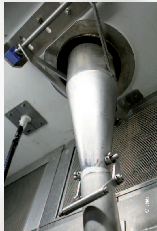
Eine Etage tiefer: Das bewegliche Abwurfrohr führt zum Verteilsystem
